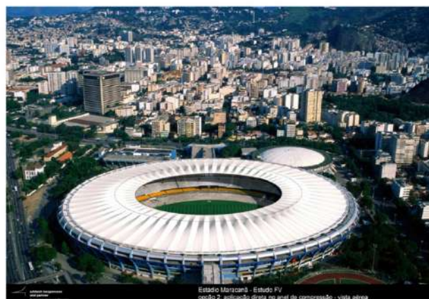
Figura 1- Em 2014, o estádio do Maracanã ganhou um sistema de geração de energia fotovoltaica em sua cobertura, a usina tem uma capacidade instalada de 400 kWp, capaz de produzir cerca de 500 MWh por ano, o equivalente ao consumo de 240 residências.
